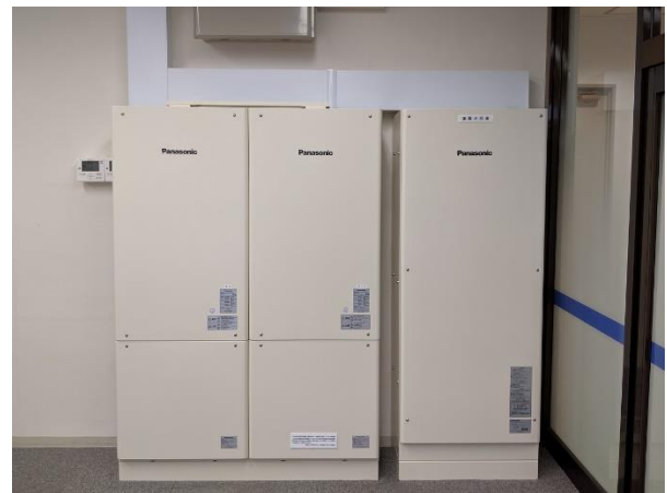
リチウムイオン蓄電池ユニット
