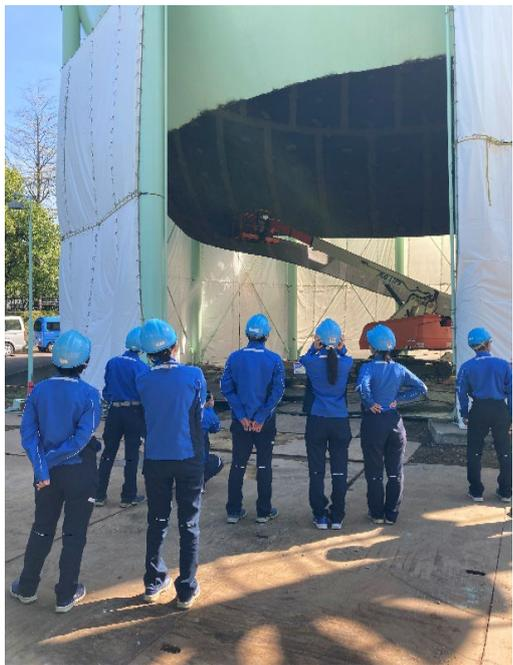
④ 球形ガスホルダー上半球のリンゴ皮むき工法による溶断作業（10月27日現在の作業状況）
