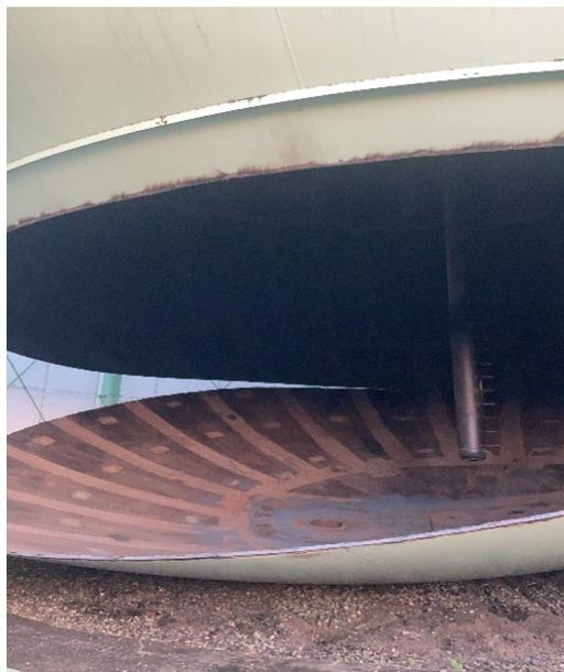
③ 球形ガスホルダー下半球のリンゴ皮むき工法による溶断作業開始
